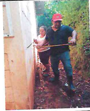
Foto 2: PINTURA EN MUROS EXTERIORES E INTERIORES
