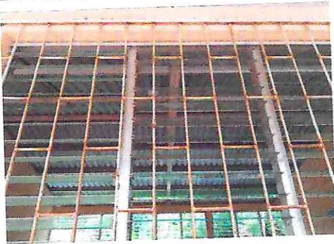
Foto 3: MANTENIMIENTO A ESTRUCTURA DE METAL DE VENTANA
