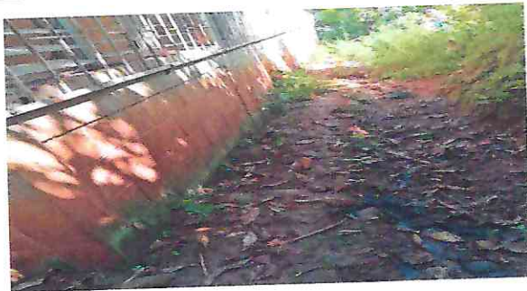
Foto 5: REPARACION DE BANQUETAS DE CONCRETO
