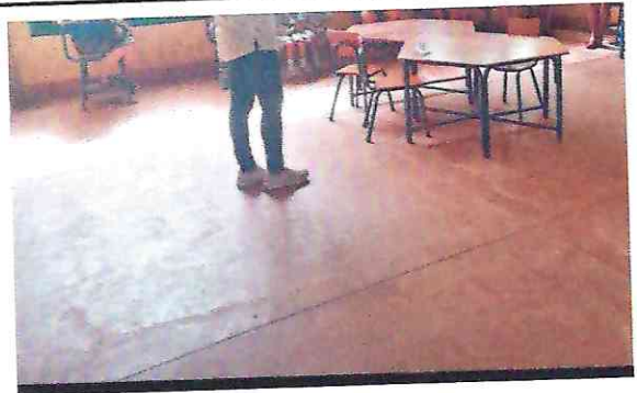
Foto 4: SUSTITUCION DE PISO CERAMICO
