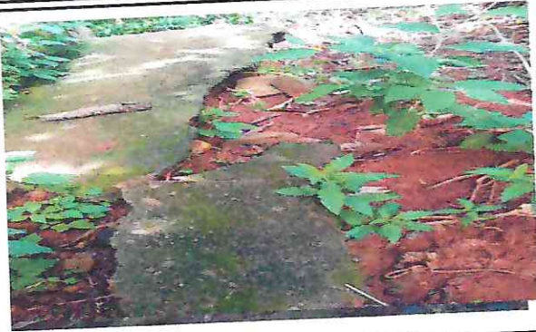
Foto7: REPARACION DE PLANCHAS DE CONCRETO DE PATIO
